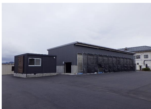
ストックヤード建築工事 （敷地北側）
