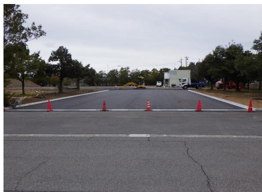
災害廃棄物仮置場整備工事 （敷地北側）
