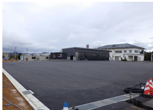
外構工事（敷地北側）
