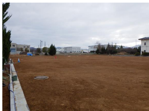
整地工事（敷地南側）
