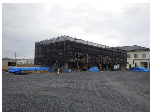
ストックヤード建築工事 （敷地北側）
