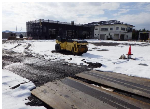
外構工事（敷地北側）
