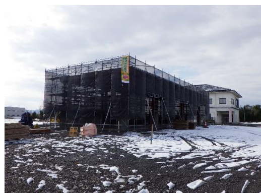
ストックヤード建築工事 （敷地北側）
