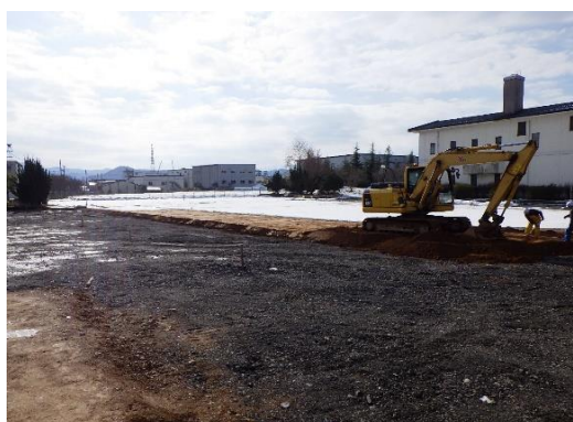
整地工事（敷地南側）
