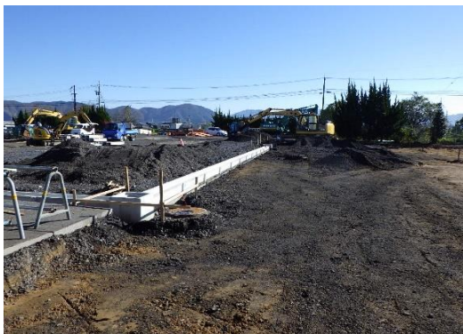
整地工事（敷地南側）
