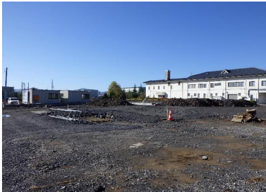
外構工事（敷地北側）
