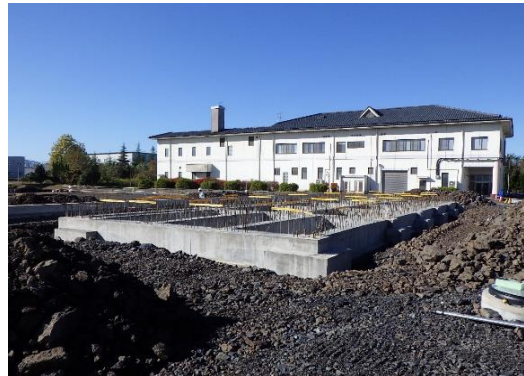
ストックヤード建築工事 （敷地北側）
