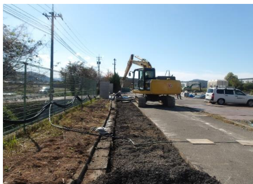
外構工事（敷地東側）
