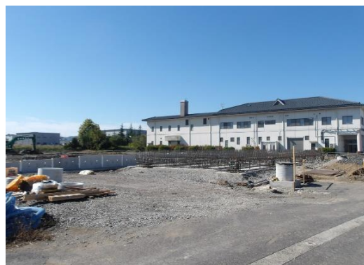
ストックヤード建築工事 （敷地北側）
