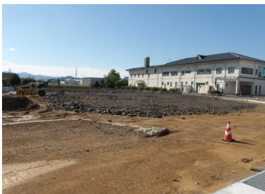
外構工事（敷地北側）
