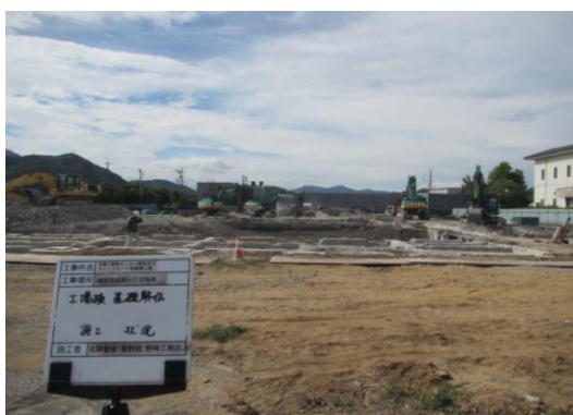
工場棟解体工事（敷地北側）
