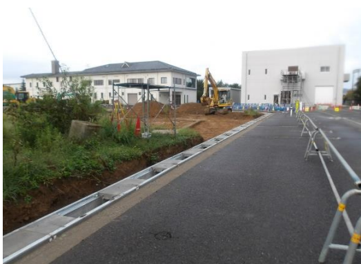
ストックヤード外構工事 （敷地北側）
