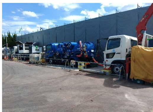
車庫・倉庫壁石綿含有塗材除去工事 （敷地南側）
