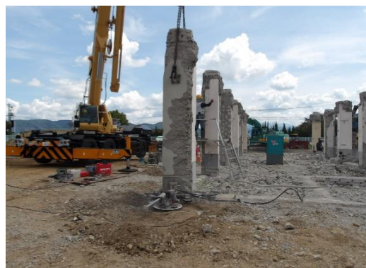
工場棟解体工事（敷地北側）
