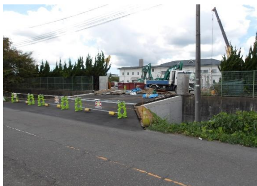
進入路整備工事（敷地東側）
