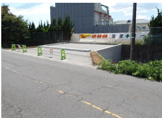
進入路整備工事（敷地東側）
