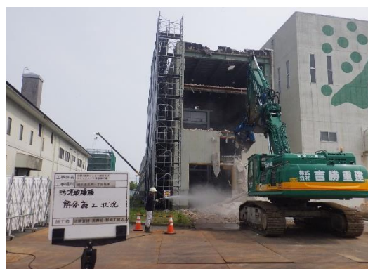
汚泥乾燥棟解体の写真
