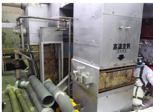
工場棟内機器解体の写真
