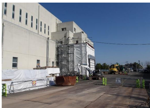
地上からの写真（東面）
