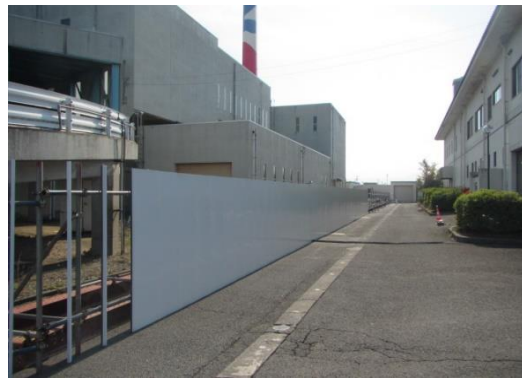
地上からの写真（西面）
