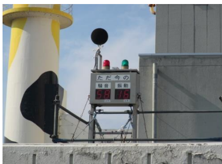
地上からの写真（東面）
