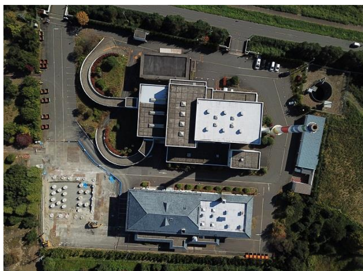
着工前全景（上空からの撮影）
